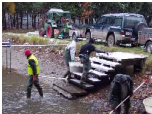
Treppe zur Abfischgrube
