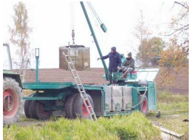
Tieflader mit Transportbehälter und Kran
