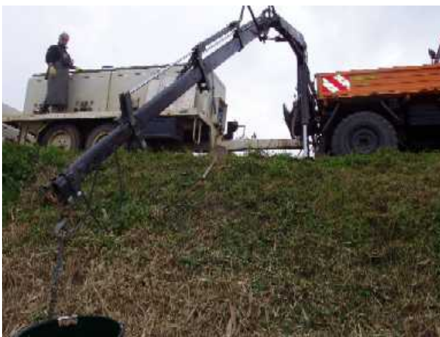
Abfischrinne aus Aluminium am Ablaufrohr
